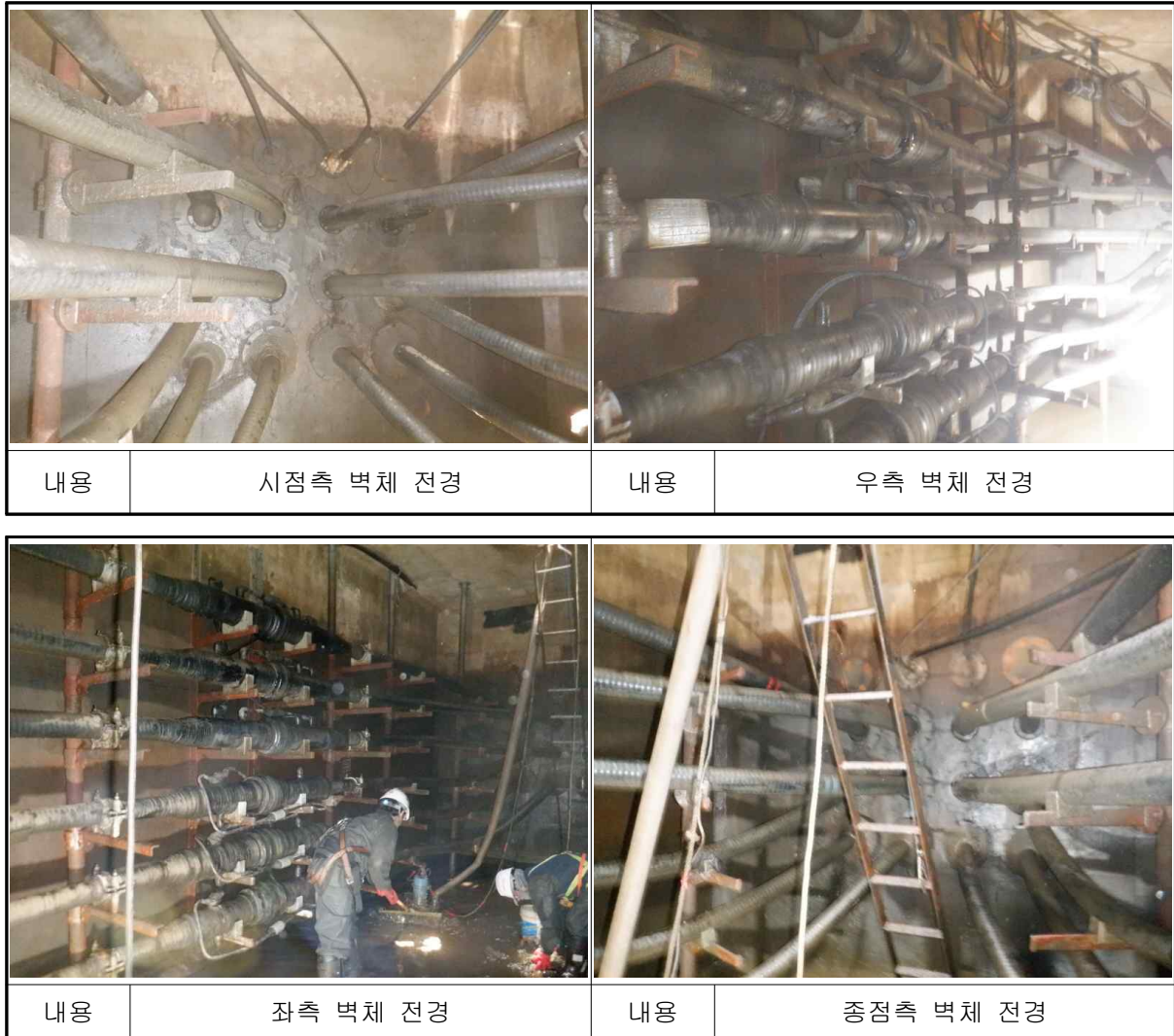
[사진 14.37] 일산~송포#10 전경
