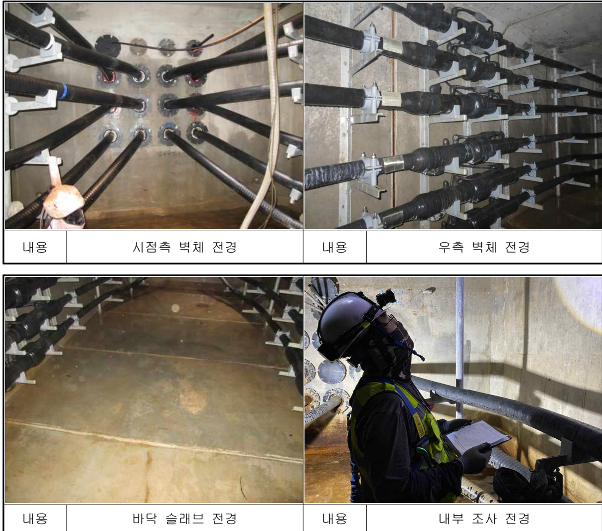
[사진 14.13] 일산~송포#4 전경
