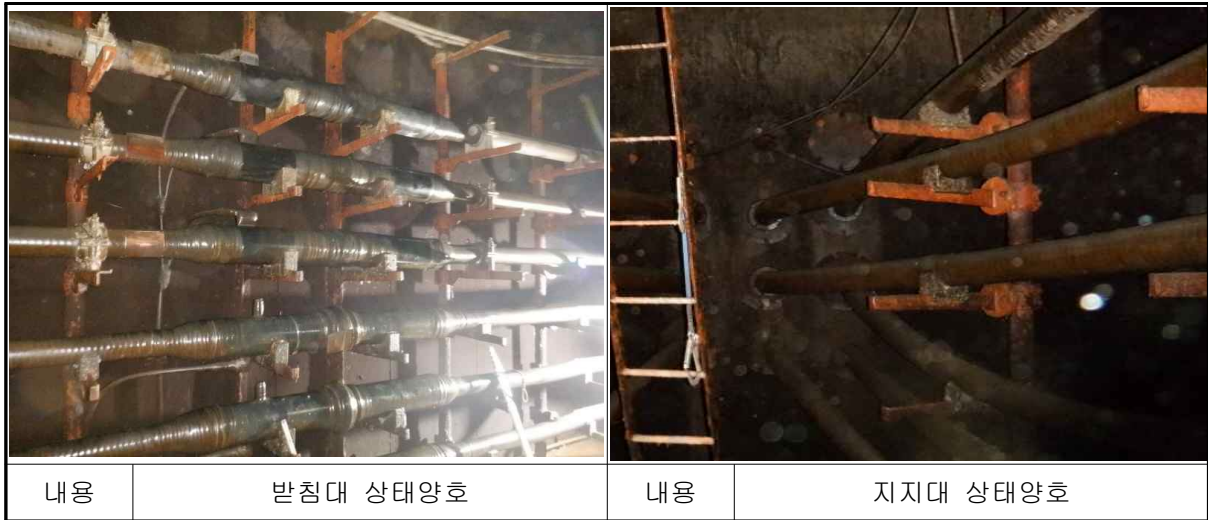
【사진 14.48】 부속 및 부대설비 현황
