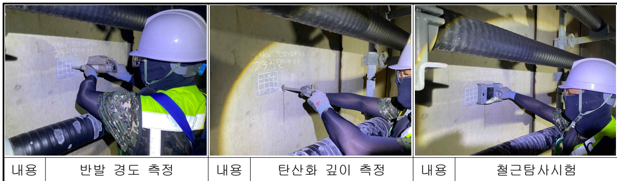
【사진 14.61】 일산송포 재료시험 전경
